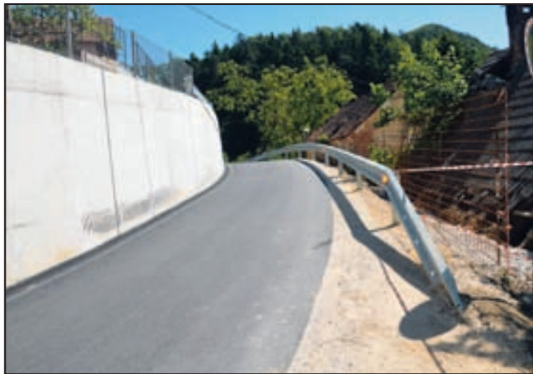
Cesta v Kavče je za zdaj obnovljena v dolžini 100 metrov, ni pa nič ožja kot prej. Vizualno prevaro, da je ožja, verjetno povzroča oporni zid.
