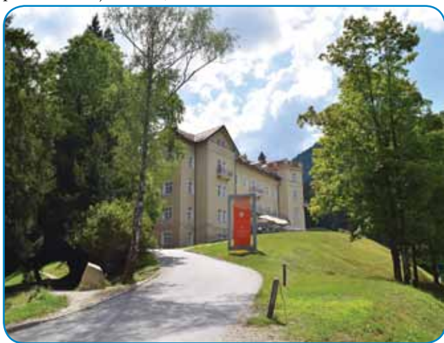
Prenovljen Sofijin dvorec v Rimskih Toplicah
