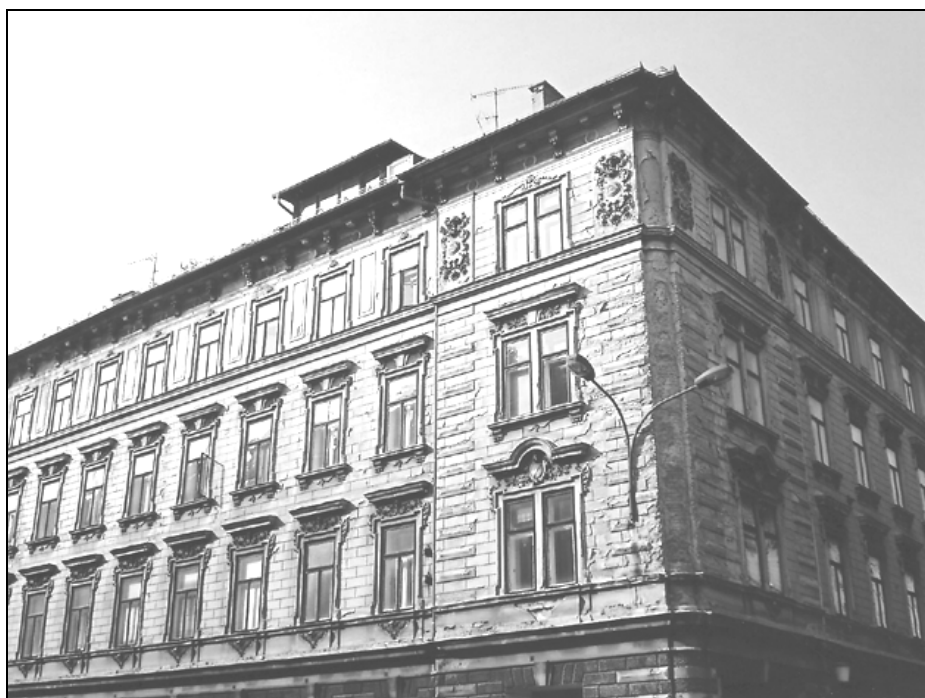
Stavbenik Viljem Treo: Gorupova stanovanjska hiša v Ljubljani, 1898 (foto: Vesna Bučič, 2005).
