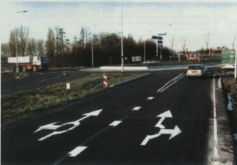
Slika 5 • Smerne puščice v enem od prvih turbo – krožnih križišč (Fortuijn, 2003)
