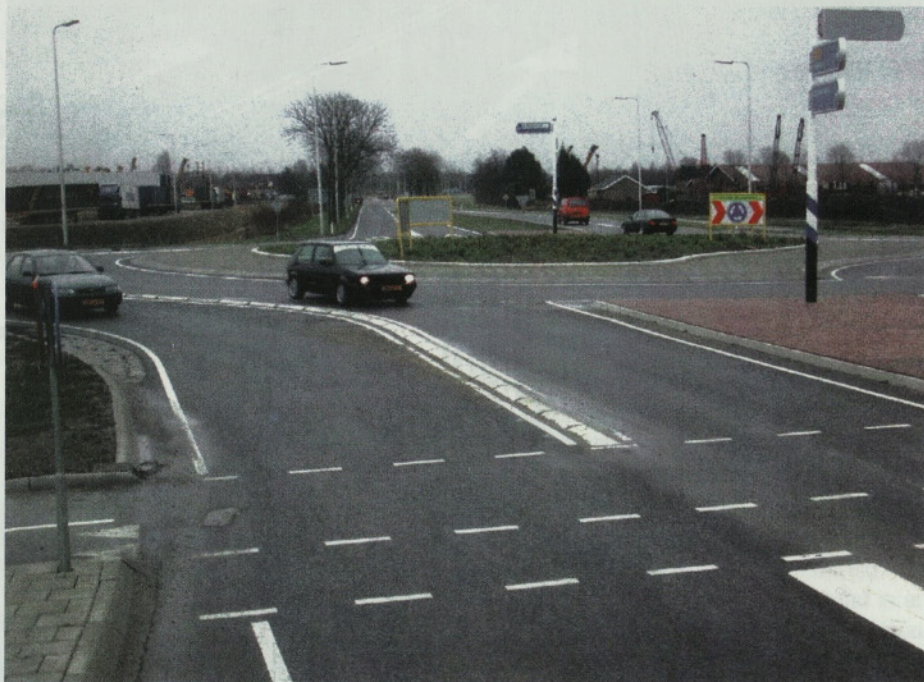
Slika 4 • Fizično ločena vozna pasova v turbo krožnem križišču (Fortuijn, 2003)
