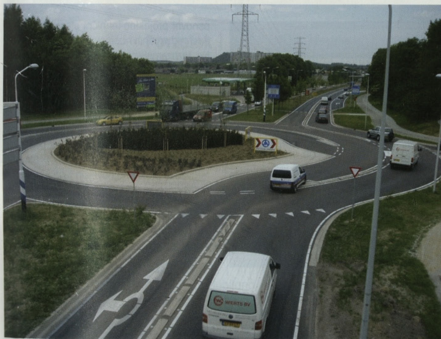
Slika 10 • Rekonstruirano krožno križišče, Heerlen
