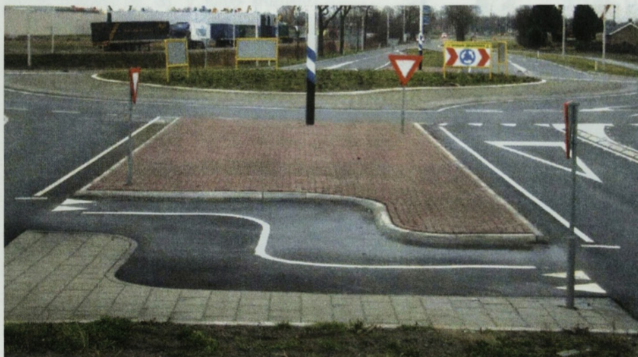
Slika 8 • Prehod za kolesarje preko kraka turbo krožnega križišča (Fortuijn, 2003)
