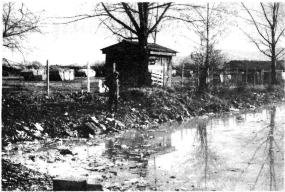
Kostakovo sanitarno deponijo v Spodnjem Starem Gradu zadnja leta redno poplavlja Sava. Škode ni malo, tako je bilo tudi jeseni, ko je voda odnesla lep kos zaščitne ograje. Bolje je, da tudi ne razmišljamo o tem, kaj poplave pomenijo za ekologijo, podtalnico in še kaj. Nove lokacije od nikoder, ker take reči pač nihče ne mara blizu sebe...
