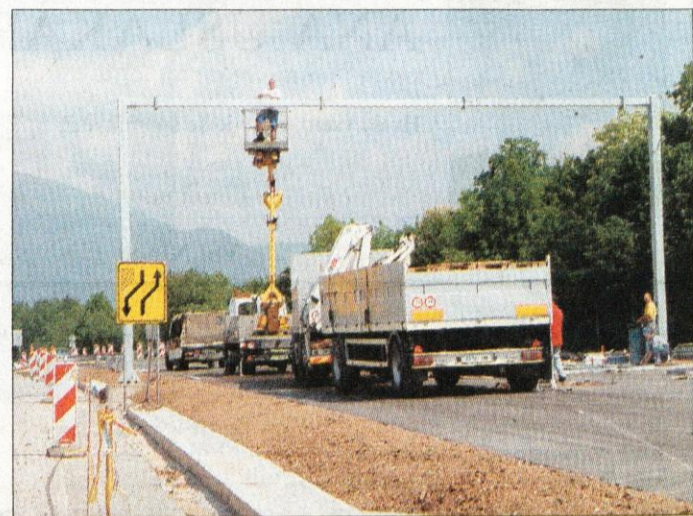
Na odprtih delih avtocestne trase montirajo prometno opremo.
