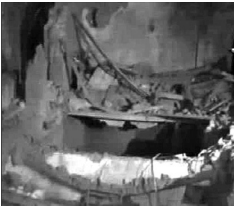
Ruševine bombardiranega bunkerja v Tripoliju
