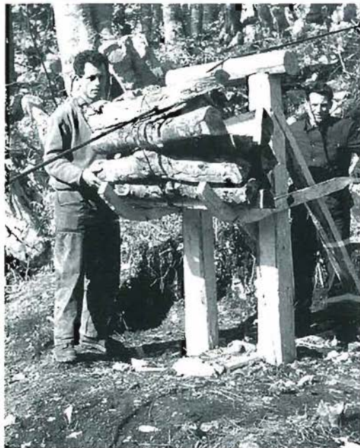
Tovor je pripravljen za spust po žični drči
