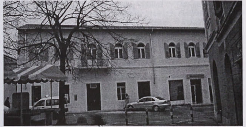
Stavba v kateri domuje tudi sejna soba občinskega sveta je dobila novo streho in novo fasado, ob sedanjih najemnikih pa bo kmalu dobila še Cyber Caffè, ki ga bodo upravljali izolski mladinci.
