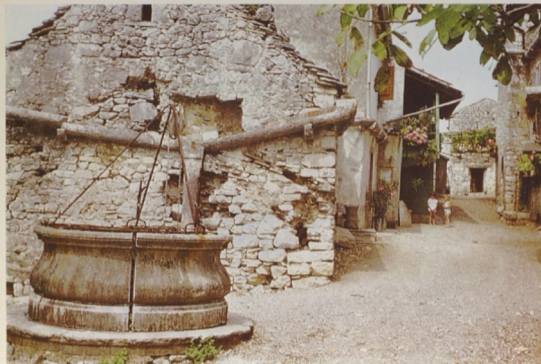
Kraška hiša z vodnjakom v Stanjelu. Na sliki se lepo vidijo kamniti žlebovi, po katerih se deževnica steka v zanimivo oblikovan vodnjak.
