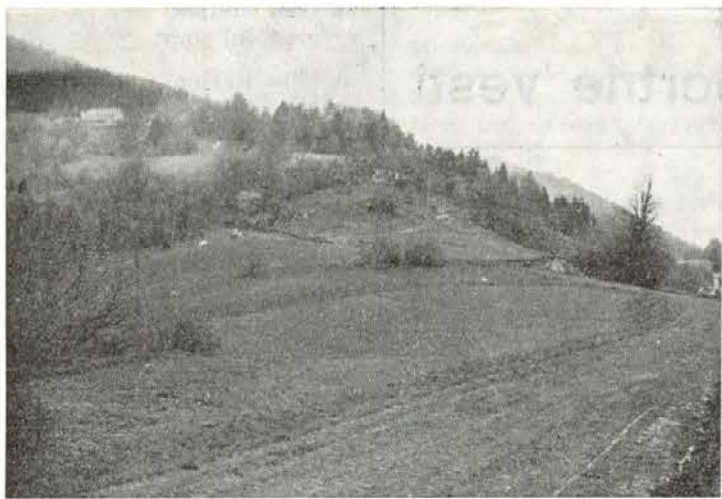
Začetek gradnje nove ceste, ki bo povezovala Trbonje z Otiškim vrhom — Foto: T. Modic
