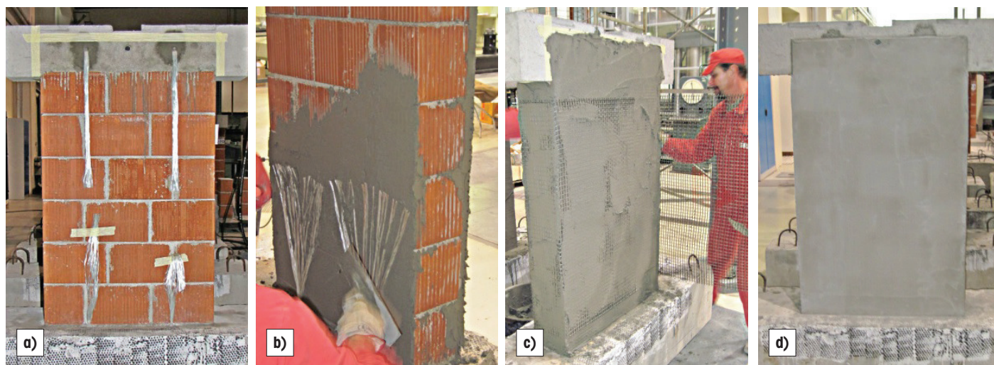
Slika 12 • a) Vgradnja sider iz steklenih vlaken; b) nanos malte in razprostiranje sidrskih vlaken; c) nanos plasti malte čez vertikalni trak in izvedba ojetja zidu; d) zidni preizkušalec v utrjenem stanju.
