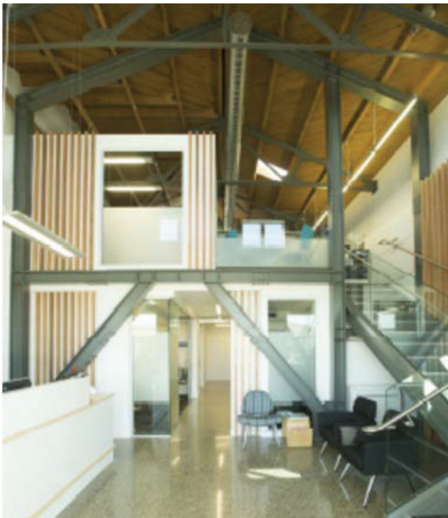
Slika 23 • Z vidnim jeklenim okvirjem utrjena stavba.
