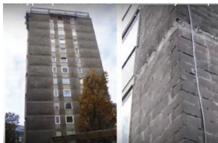
Slika 5 • Potresno neodporna stanovanjska stolpnica v Ljubljani.
