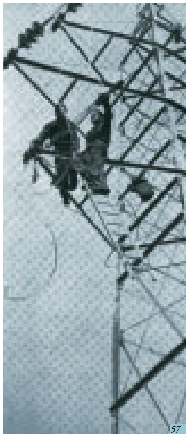
Gradnja daljnovoda 2x35 kV Kleče-Logatec.
