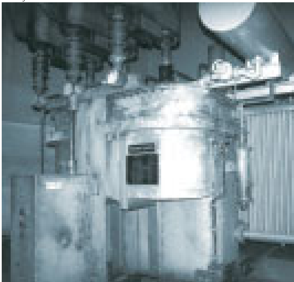
Avtotransformator z 10kV za usmerniški transformator 10kA skupine obratuje od leta 1954.
