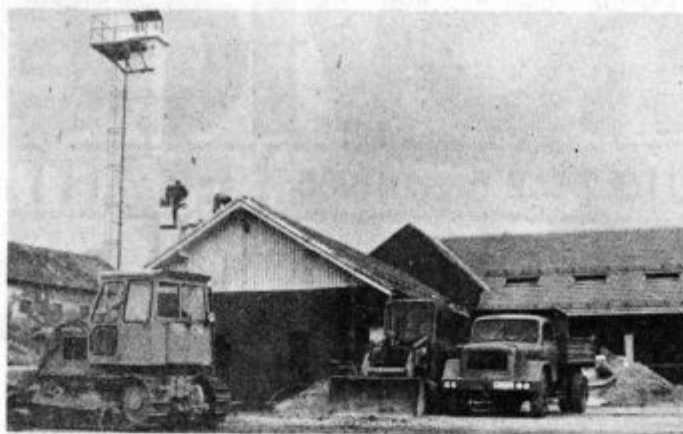
Izvajalci gradbenih del — delavci lenarškega »Centrovoda« so držali objlubo in veterinarsko postajo zgradili v dogovorjenem času.
