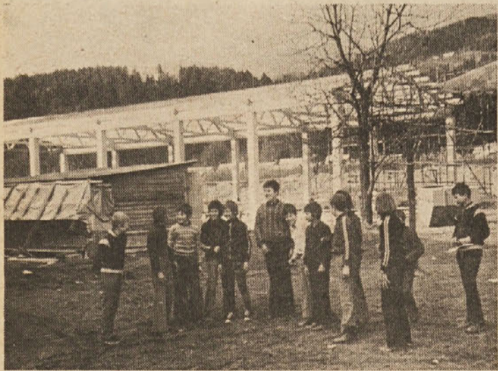
„Okostje“ nove telovadnice je že postavljeno. Zdaj bodo dela potekala hitreje in že jeseni se bodo odprla poleg šolskih vrat še vrata nove telovadnice. (Foto: T. Urbas)
