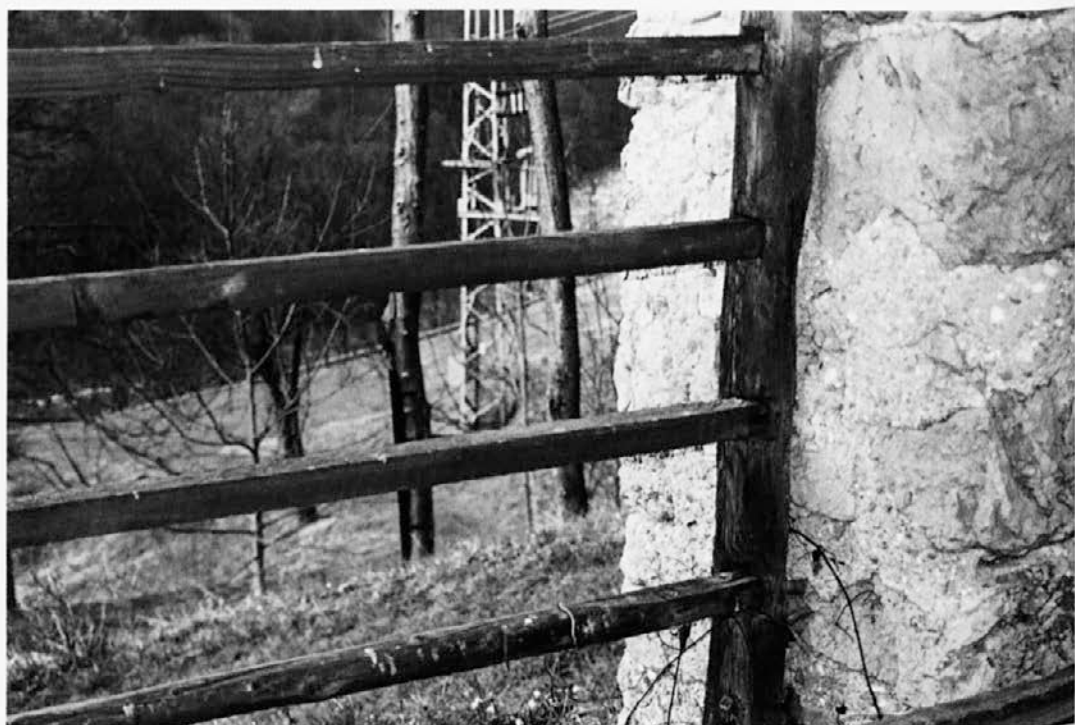
Sl. 13: Detajl lesene opore z latami v zidanem stebru kozolca, Stopnik 6 (foto: T. Cevc, 2001)
