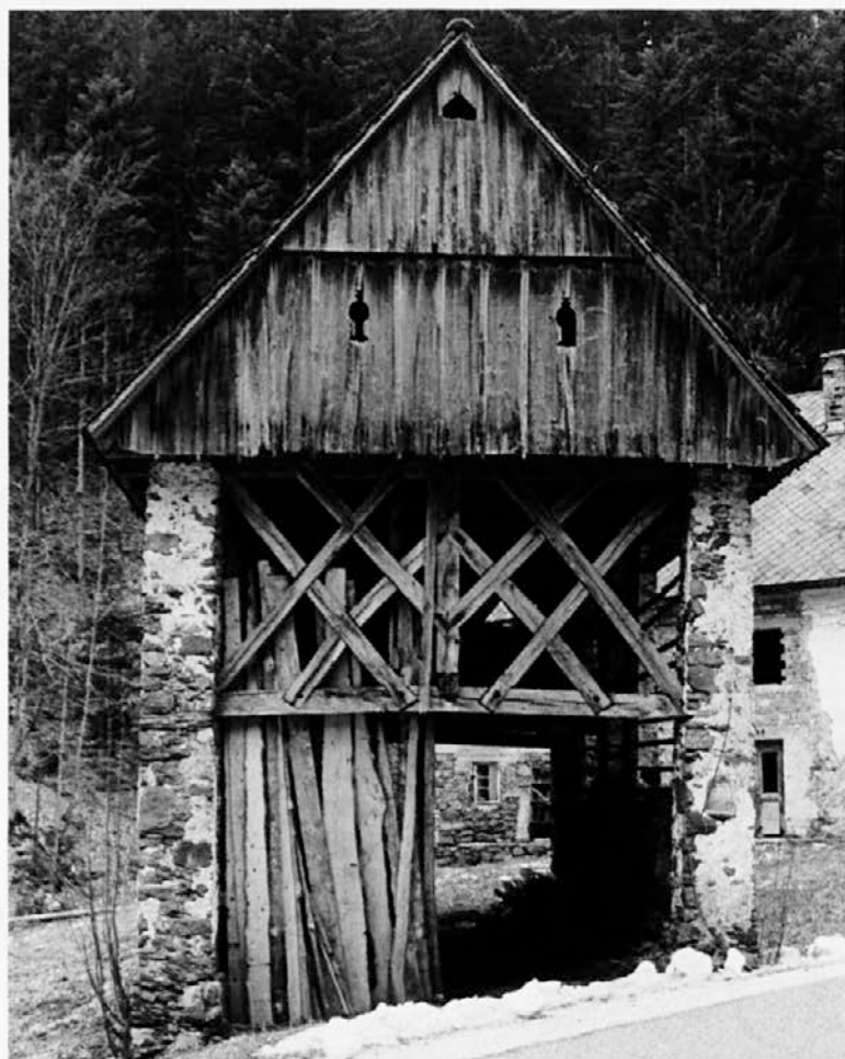
Sl. 3: Kozolec iz l. 1833 z zidanimi stebri iz hotaveljskega rdečkastega apnenca, postavljen na meji med cerkljanskim in škofjeloškim ozemljem, Koprivnik pri Sovodnju (foto: T. Cevc, 2001)
