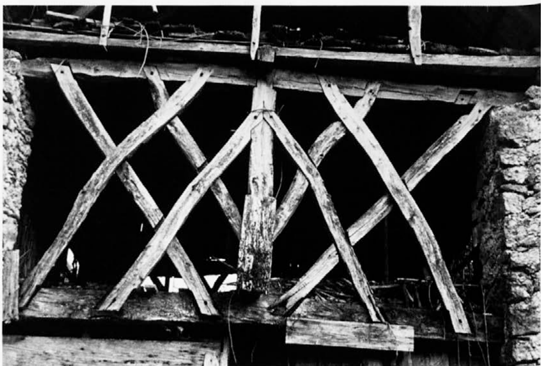
Sl. 14: «Križi», stesani iz lesa listavcev, zapirajo nadstropni del čela kozolca in povezujejo lesene dele konstrukcije stavbe (foto: T. Cevc, 2001)
