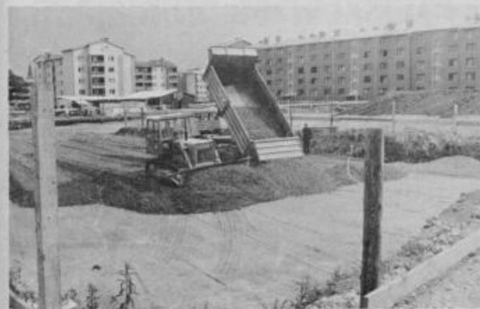
Na kompleksu Rabeljčje vasi bo zrasel naj-sodobnejši stanovanjski predel Ptuj. Po arheoloških raziskavah sta dva 90 stanovanjska bloka že zgrajena, dva sta v gradnji, devet pa jih bo še zgrajenih v naslednjih letih. Foto: R
