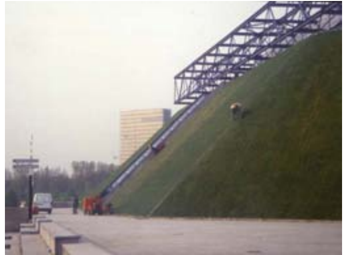
Slika 12: Intenzivno gojena trava na strmih stenah športne dvorane v Parku Bercy v Parizu je primer nesmiselnega načrtovanja zelene strehe - stene, saj zahteva izjemno visoko stopnjo dragega vzdrževanja. (foto: Tanja Simonič)
