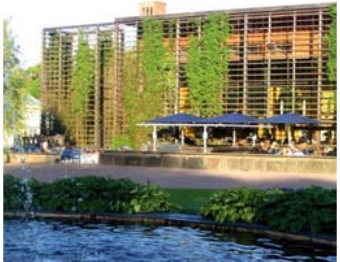
Slika 6: Vertikalna konstrukcija za vzpenjalke kot zelena stena javnega objekta v mestnem parku v Göteborgu (foto: Tanja Simonič). Vertical support structure for climbers as a green wall of a public building in the Gothenburg city park.
