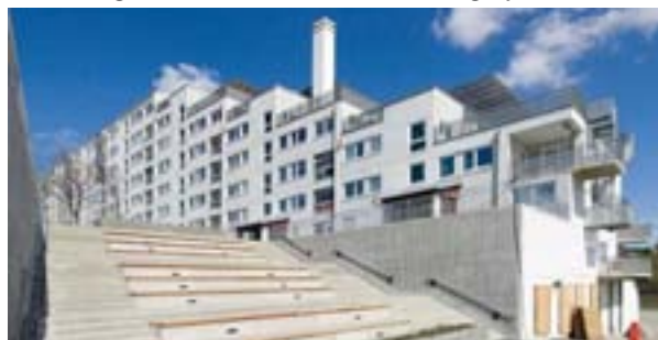
Slika 2: Objekt po prenovi v soseski Gardstan v Göteborgu, s terasasto urejenimi strešnimi vrtovi (foto: Anders Thor).
