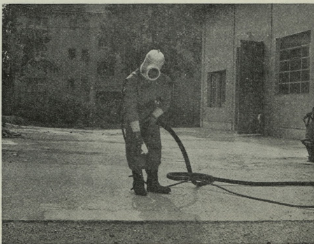
Aparatura za peskanje, torkret in brizgani beton
