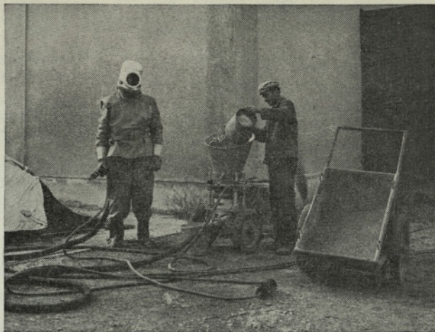
Peskanje betonske plošče
