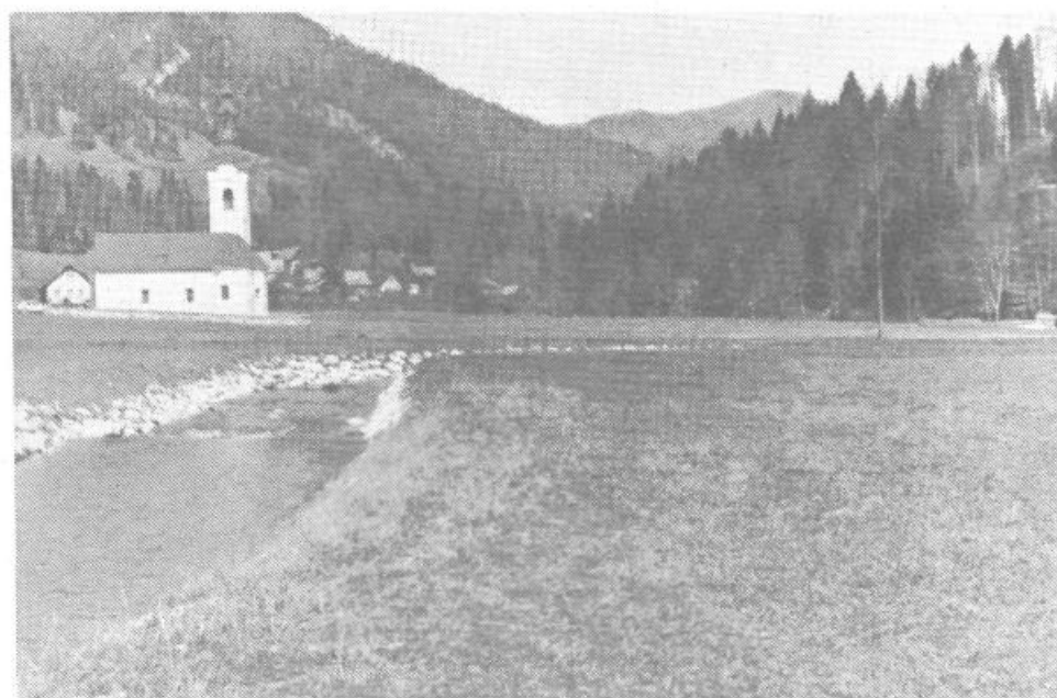
Potem, ko so delavci PUH Ljubljana regulirali tok Male vode, so nastale v Brišah zanesljive, stalne in kakovostne obdelovalne površine
