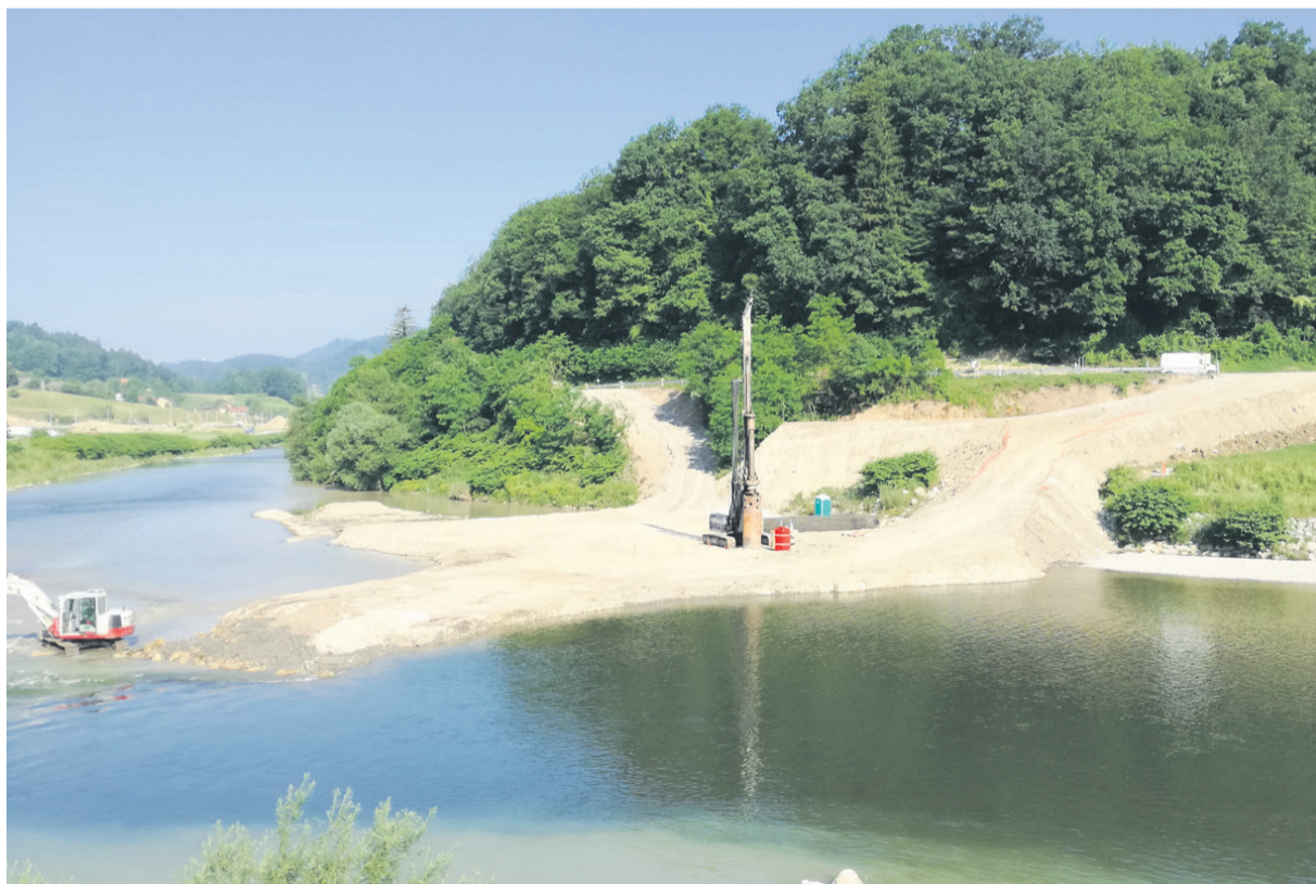
Gradbišče v Marija Gradcu za nov most čez Savinjo
