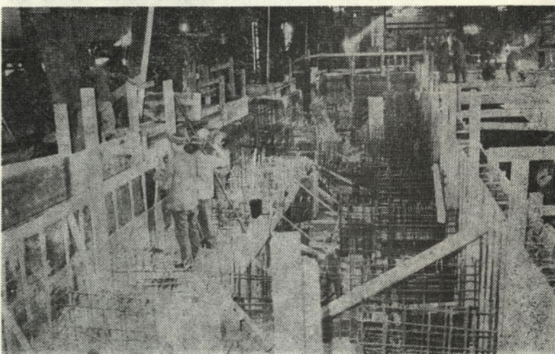
Priprave za betoniranje temeljev hladilne klopi — avgust 1981
