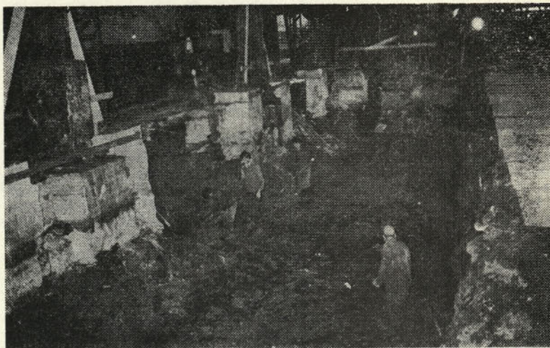
Izkopi temeljev za hladilno klop v valjarni I. — julij 1981
