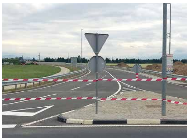
Vsa gradbena dela bodo predvidoma zaključena do konca septembra, nato pa sledi še tehnični prevzem manjkajočega dela obvoznice v občini Mengeš
