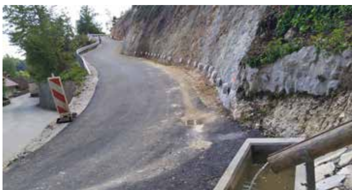
Vzporedno z rekonstrukcijo ceste Dobeno–Studenc na Spodnjem Dobenu je bilo obnovljeno tudi vodno korito, ki je sedaj umeščeno tako, da je pohodnikom in kolesarjem ob osvežitvi omogočen varen postanek
