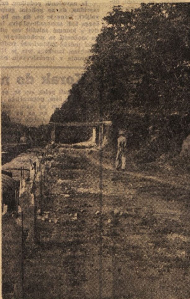
Zaradi del na novi rampi in nakladalni postaji so minule dni odstranili stroje z dosedanje rudniške rampe
