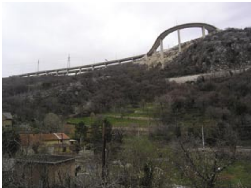
Bakar s kulturnimi terasami, ki so domicil Bakarske vodice, in novo prometno infrastrukturo (foto: Primož Pipan).
