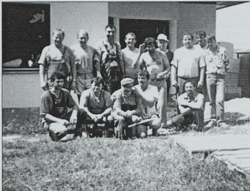
Udarniška skupina pod vodstvom Mirka Čeha in Stanka Majeriča po položitvi izolacijskih betonov.
