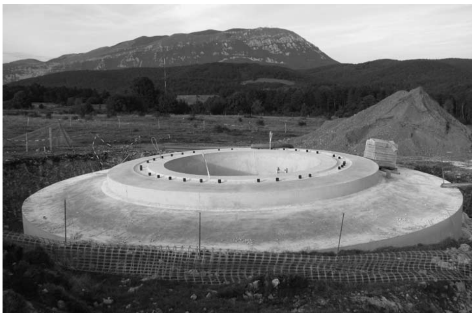
Slika 3. Betonski temelj vetrne elektrarne Dolenja vas
