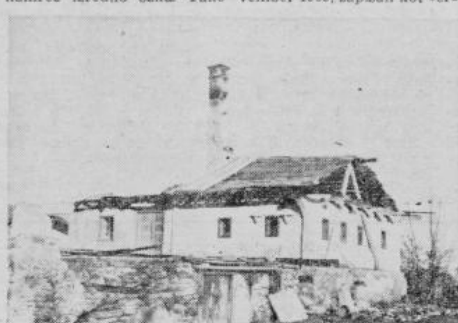
Ačkovim je zgorelo gospodarsko poslopje in hiša. Ostali so le zidovi. Na posnetku vidimo že zasilno pokrito stanovanjsko hišo, da voda ne bi pritekla v klet.
