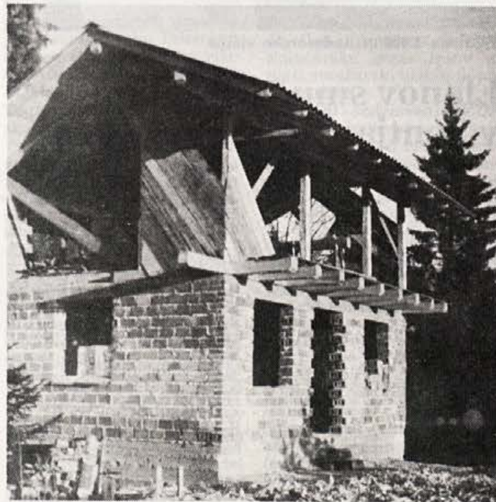
Sankaški dom v gradnji
