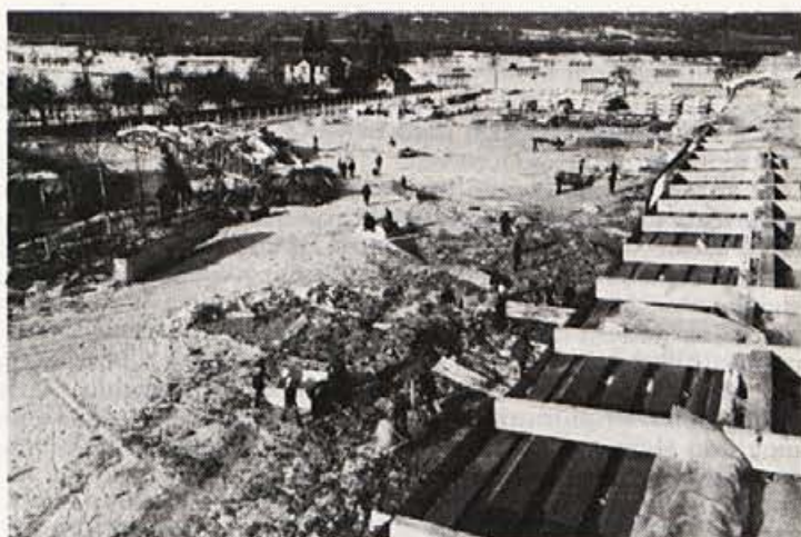
Vse ruševine na strehi obrata Plastike so prostovoljci z udarniškim delom odstranili
