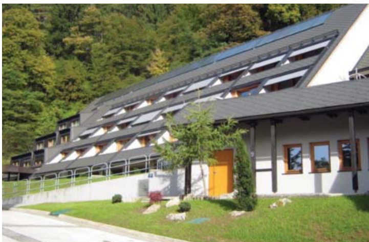
Dom starejših občanov Preddvor - prenovljeni del
