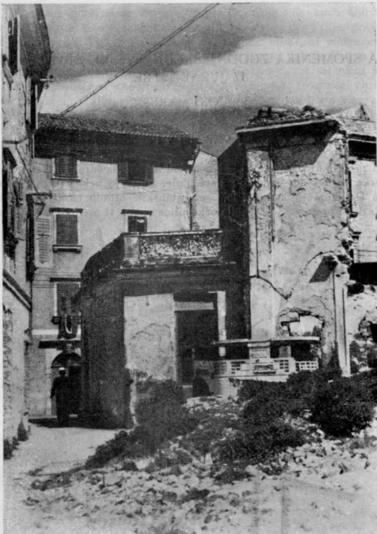
Sl. 1. Pogled na ruševine hiše št. 1 (bizantinska cerkev) v ulici sv. Mikule in hiše št. 4 v ulici 8. maja
