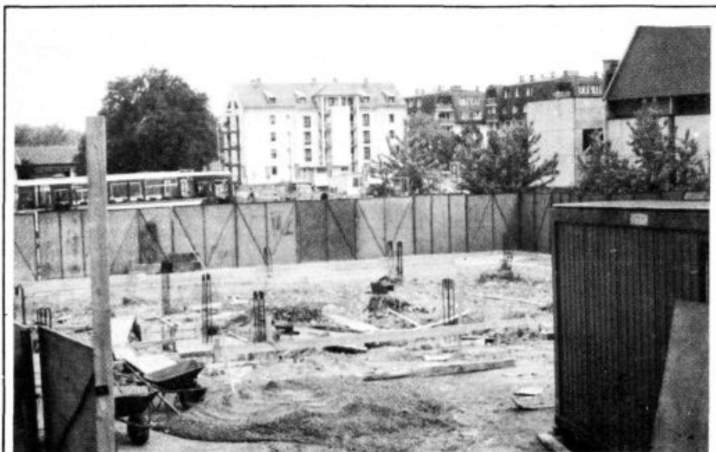
Pogled na gradbišče avtobusne postaje Lenart. Že letos bi naj pričeli z deli na bližnjem kulturnem domu.
