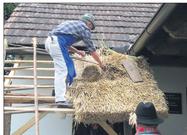
Mojster za pokrivanje Ivan Belšak je takole spretno in hitro prekrival nadstrešek s slamnato streho.
