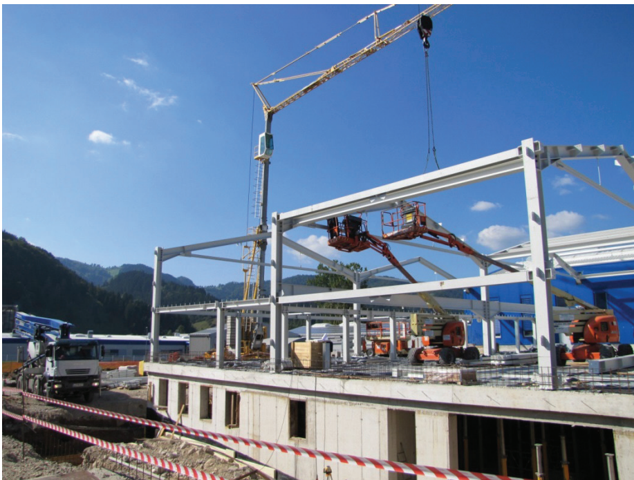
Slika 2 • Pogled na gradbeno mehanizacijo, ki so jo uporabljali pri gradnji (črpalka za beton, visoki žerjav, teleskopske dvigalne ploščadi)
