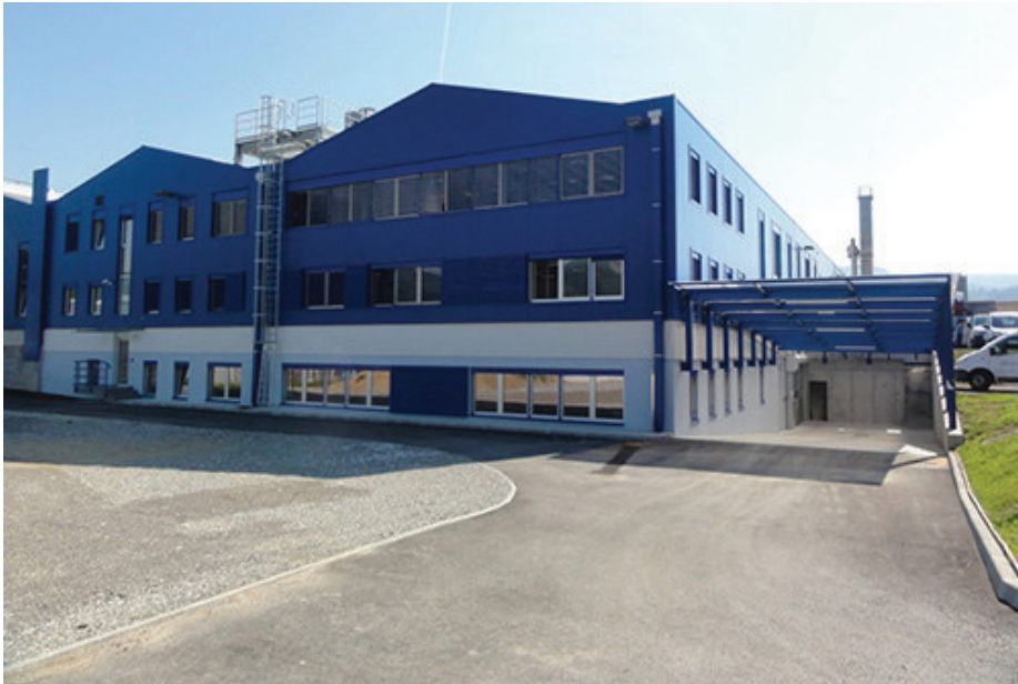
Slika 1 • Produkt – industrijska hala 4 in parkirišče Investitor objekta je bila družba, katere dejavnost je proizvodnja elementov za fluidno tehniko. Proizvajajo različne hidravlične ventile, kompresorje in črpalke. Zaradi širitve proizvodnje in prostorske stiske so se v podjetju odločili za širitev in novogradnjo industrijske hale 4 in parkirišča. Objekt je dimenzij 30 m x 40 m in se danes uporablja za proizvodnjo omenjenih delov. V objektu so pisarne, skladišče, proizvodne linije, garderobe in sanitarije
