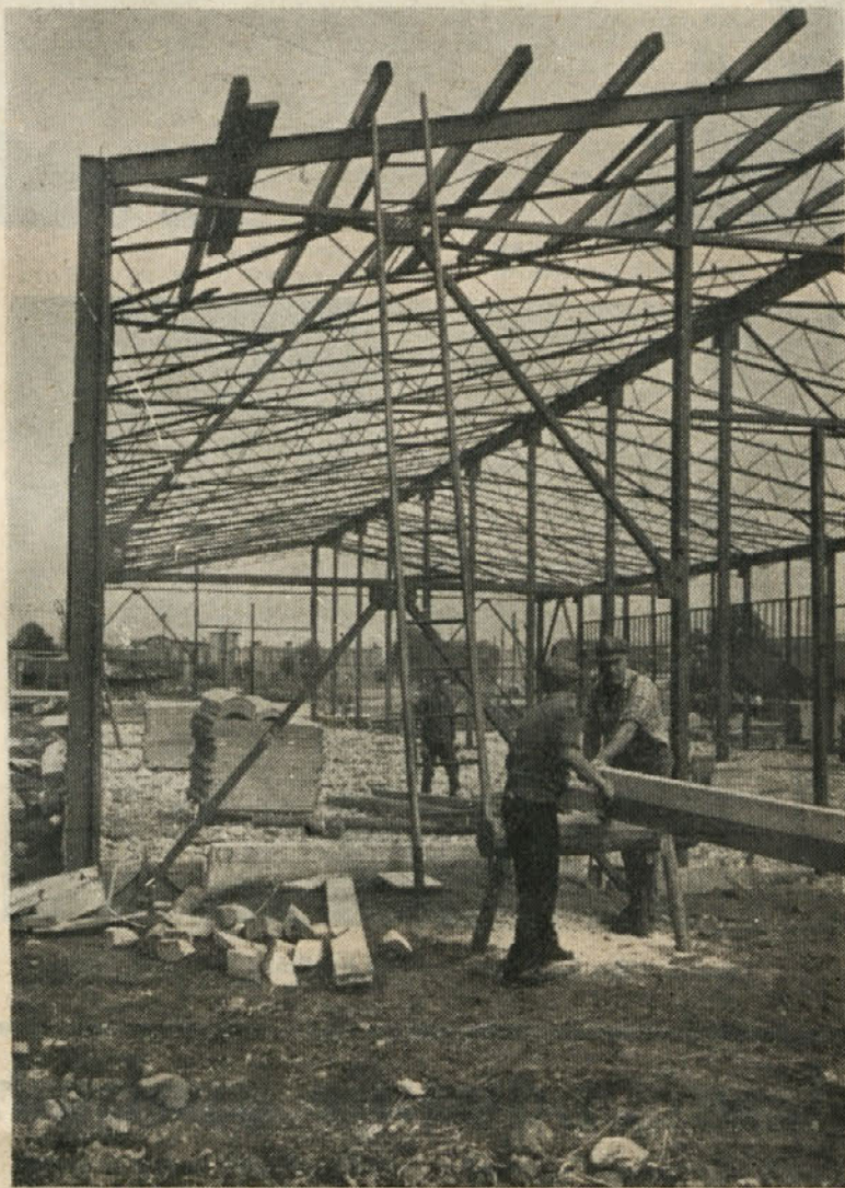
Novo skladišče, čigar ogrodje vidite na sliki, mora biti gotovo 15. oktobra
