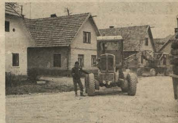
Cesto v Hrovači pri Ribnici so že razširili, še prej so vaščani uredili kanalizacijo, v teh dneh pa jo bodo še asfaltirali. Na fotografiji je krizišče sredi vasi pri hiši, kjer je bil rojen jezikoslovec Stanislav Škrabec (levo). (Foto: Primc)
