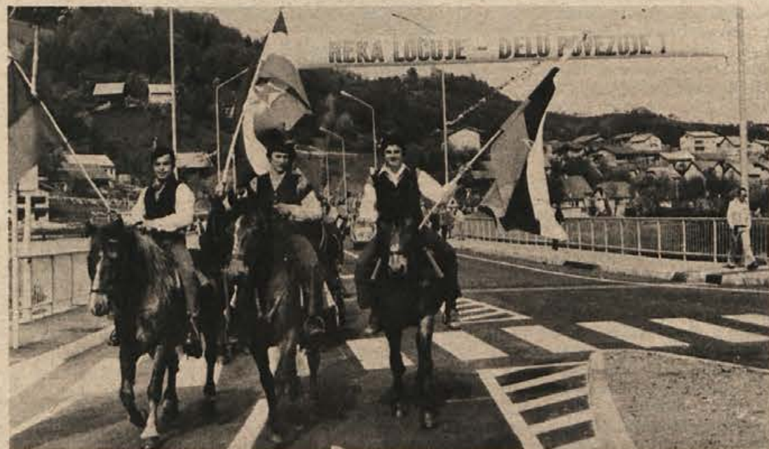
Graditelji mostu so na slavalok ponosno zapisali: „Reka ločuje - delo povezuje!“ Novi most bo opravljal svoje tudi pri „zlivanju“ Sevnice in Boštanja, še posebno ko bodo zgrajeni nekateri objekti na boštanjski strani: motel, črpalka in drugo. (Foto: Železnik)
