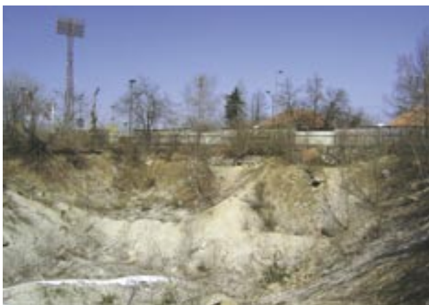
Slika 2: Profil 1 . Lokacija: območje nekdanje vojašnice med Dunajsko cesto in Peričevo ulico. Na območju nekdanjih stavb so izkopane več metrov globoke gradbene jame. Vsebuje pet horizontov. Vzorci izkazujejo rahlo bazičen pH (od 7,4 do 7,9), kar dokazuje, da so bili gradbeni odpadki, kot sta beton in malta, temeljito odstranjeni. Tip prsti: evtrična rjava prst (foto: Primož Pipan).
