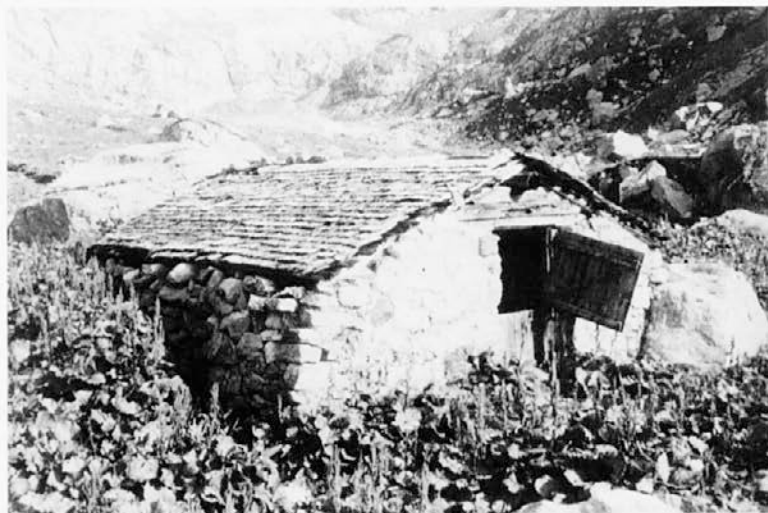
Abb. 1: Einräumige Sennhütte am Sustenpass (UR), erbaut im 20. Jh., in der Anlage und Bauweise jedoch spätmittelalterlich (Bild B. Furrer, 1986)
