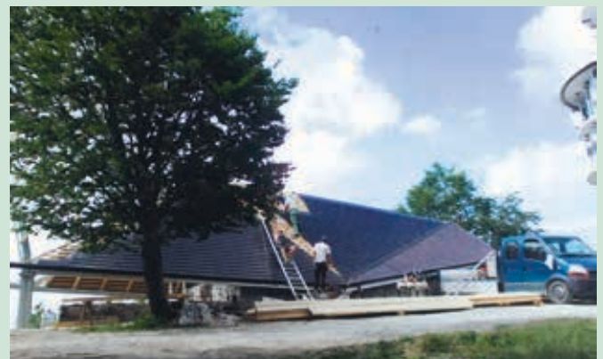
Na ruševinah stare cerkvice Sv. Jere so leta 2013 postavljali novo.
