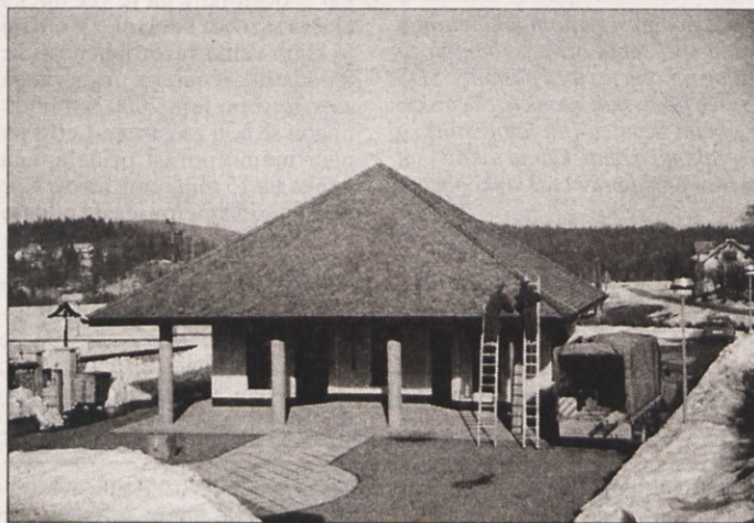
OBNAVALJAJO MRLIŠKE VEŽICE - V večini občin zahodne Dolenjske so tudi v letošnjih proračunih veliko denarja namenili tudi za obnovo ali izgradnjo mrliških vežic; največje bodo imeli v Dobropolju. Na pokopališču v Velikih Laščah pa so takoj po novoletnih praznikih zamenjali dotrajano kritino. (Foto: M. Glavonjič)
