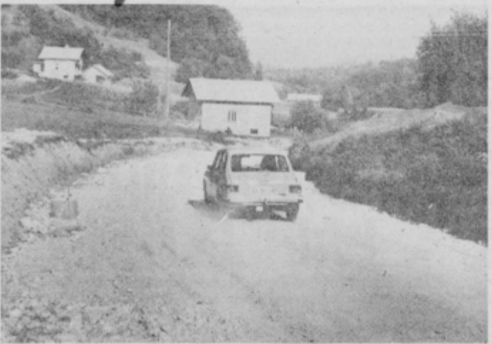
Del obnovljene ceste
