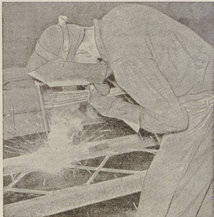
Na nezaščitenih varilnih mestih se dostikrat pripeti, da si delavci poškodujejo oči. Tudi ta varilec se ne zaveda svoje dolžnosti v skrbi za varnejše delo — ni zaščitil svojega delovnega mesta.
