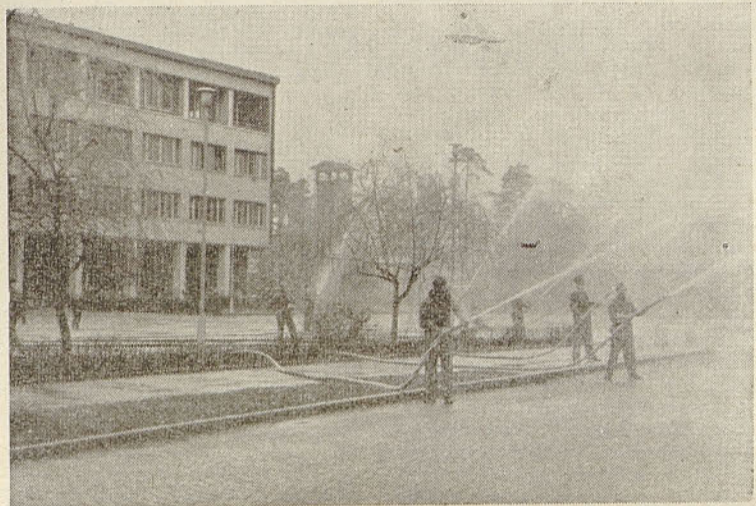
Gasilska vaja pred upravnim poslopjem
