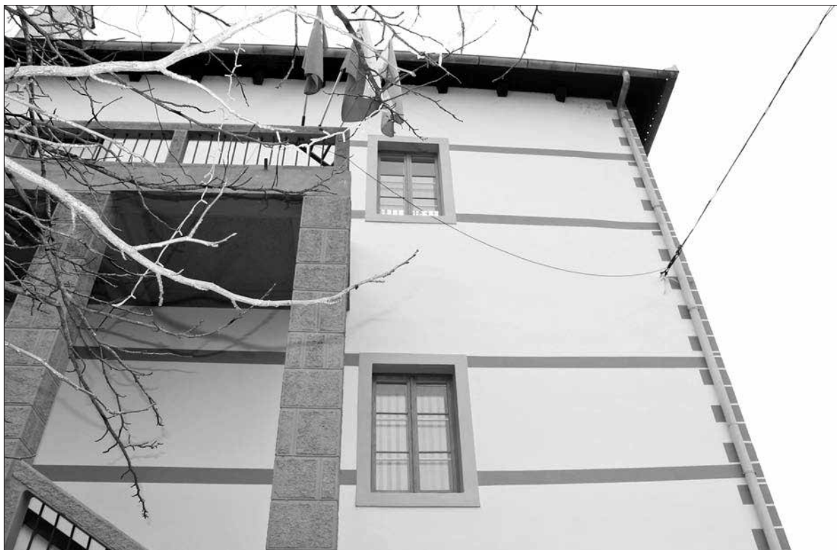
Detajl novega stavbnega pohištva črnomaljskega gradu (foto Neva Makuc).
