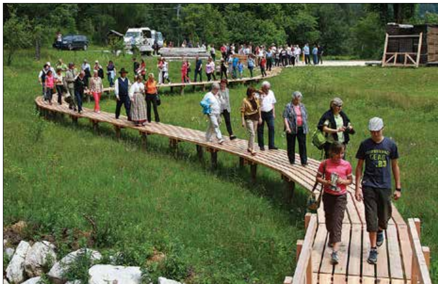
Pri Žibovtovich nad Logarsko dolino so nad močvirjem zgradili pohodno macesno stezo.
