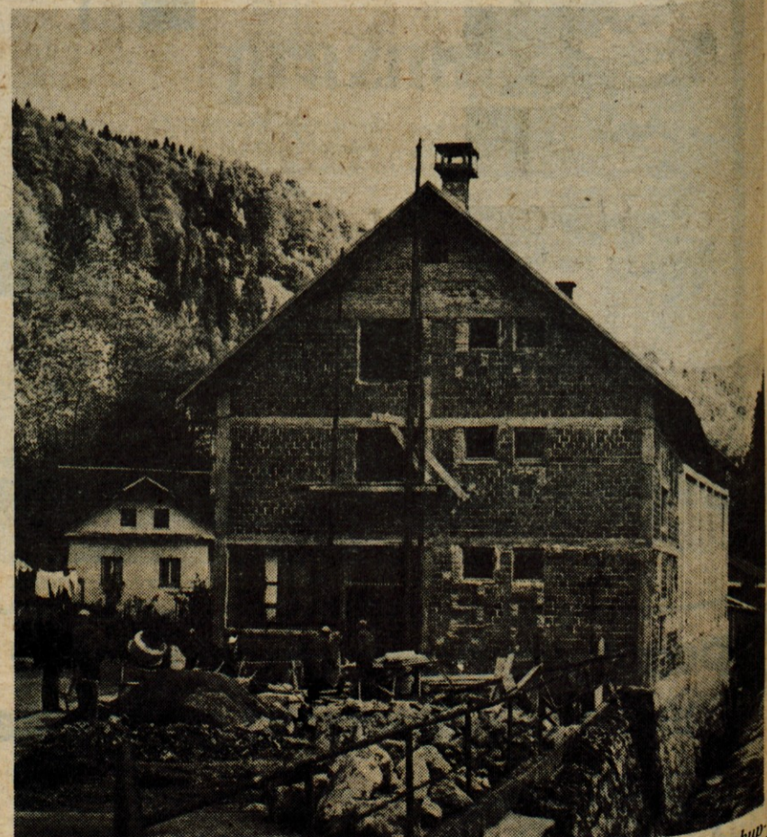
Obnova kulturnega doma v Železnikih je že nekaj let naloga krajevne skupnosti. Lani so uredili dvorano in ogrevanje, prav v teh dneh pa so spravili pod streho prizidek doma. V njem bodo uredili razne pomožne prostore in bife. — Foto: F. Perdan
