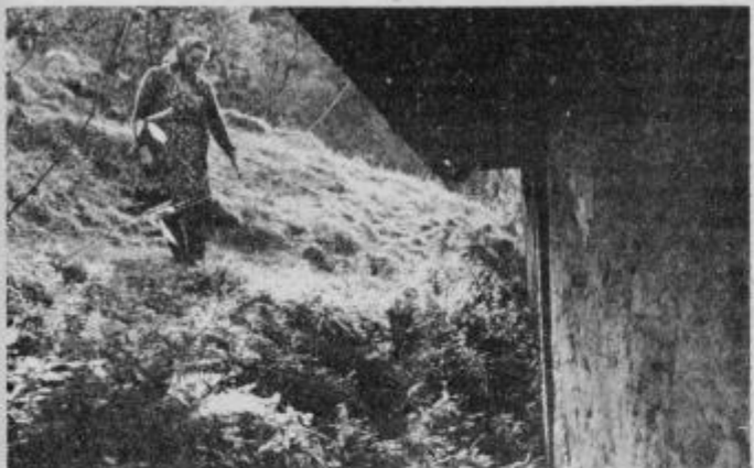
»Tukaj se vidi razpoka nad hišo. Ves hrib se je primaknil hiši,« pravi zaskrbljena Marija Korez.
