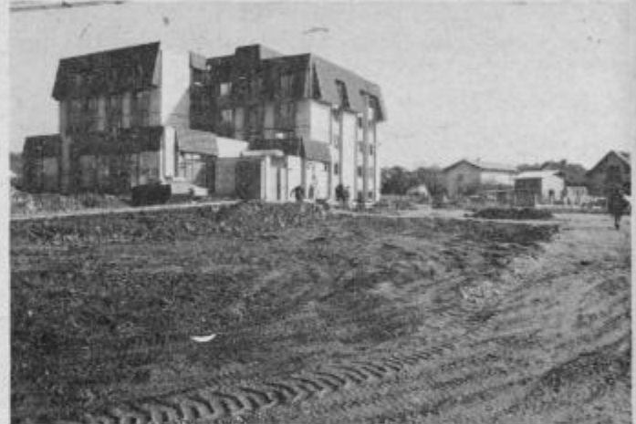
Urejanje okolja v neposredni bližini gradbišča
