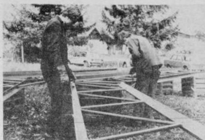
Učenci pri delu za zaščito kovinskih konstrukcij Foto: I. Ciani
