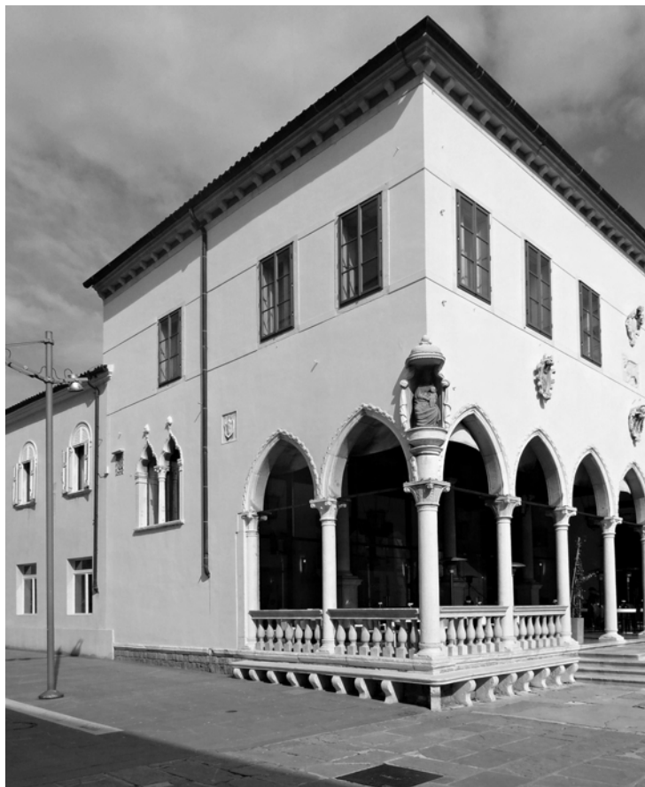
1. Koper, Loža, zahodna fasada / Koper, Loggia, western façade
