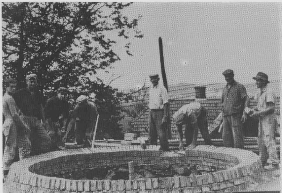
Lukmanovo apnenico obnavljajo, Podpeč 1966
