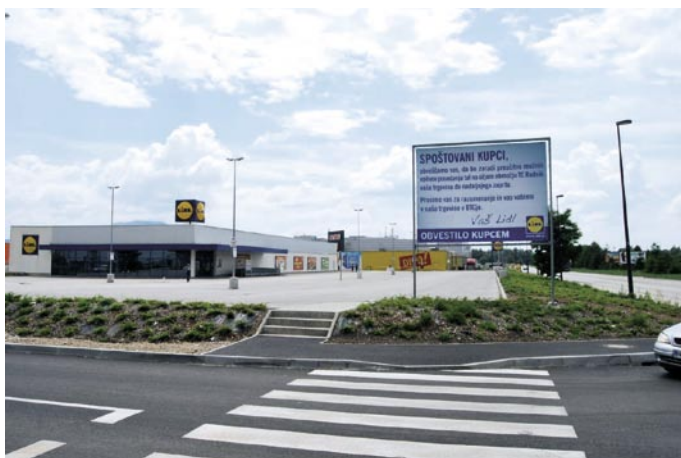
Slika 6 • Zaprtje trgovine Lidl na Rudniku v Ljubljani zaradi posedanja tal bi lahko bila posledica »geološkega presenečenja«, če ne bi za njim stal nezasiščen primer goljufanja z geotehničnimi podatki
