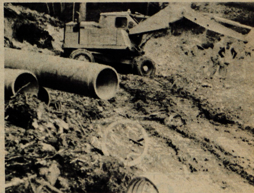
Delavci SGP Sava Jesenice opravljajo vsa zemeljska dela pri graditvi novega jeseniškega vodovoda. — Foto: B. B.
